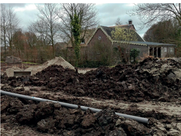
De Wijktuin Achterveld&Groenvliet in aanleg
